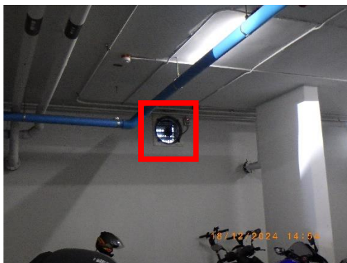
รูปที่ 2-54 ระบบระบายอากาศจากชั้นจอดรถ
