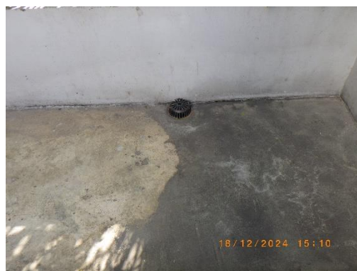
รูปที่ 2-16 ตะแกรงดักขยะ
