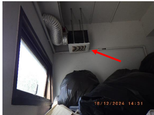
รูปที่ 2-24 ช่องดูดอากาศภายในห้องพักมุลอย
