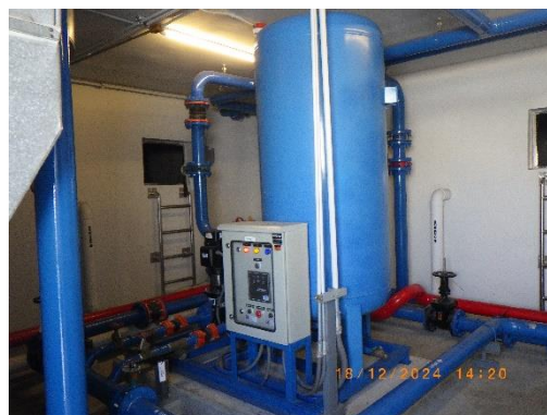
รูปที่ 2-10 ถังเก็บน้ำคาดฟ้า
